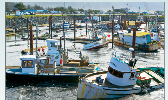
Todos los daños al pequeño muelle del puerto de Crescent City fueron causados por corrientes fuertes y ocurrieron más de dos horas después de que llegara la primera ola del tsunami.
