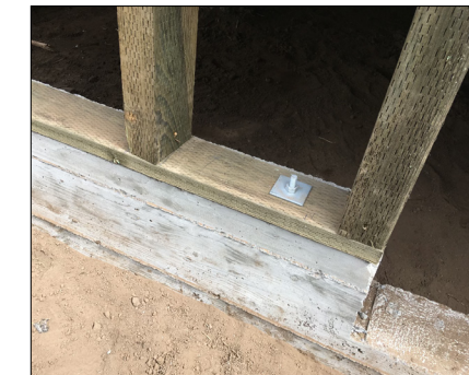
Casa atornillada a los cimientos
